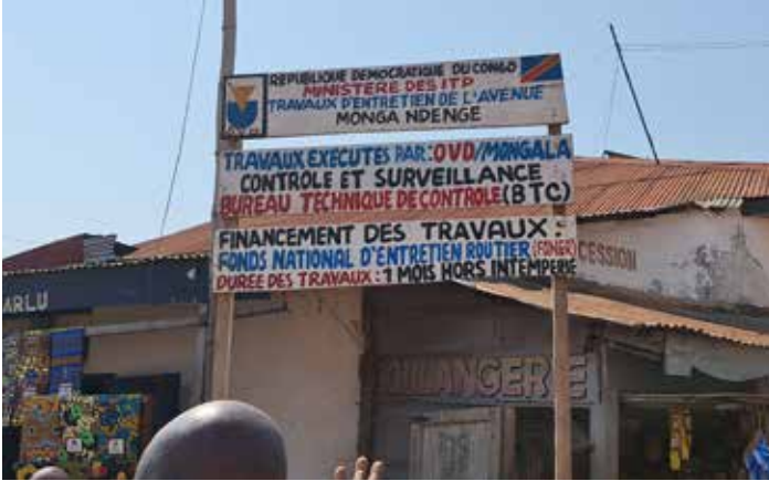
Travaux d'entretien de l'avenue Monga ndenge ( Mongala )
