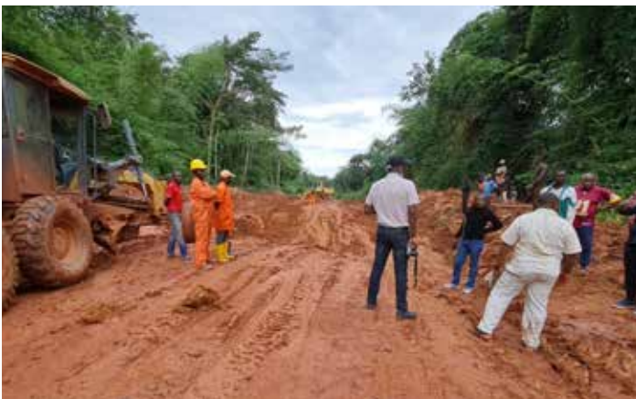
RN 4 Lancement des travaux
