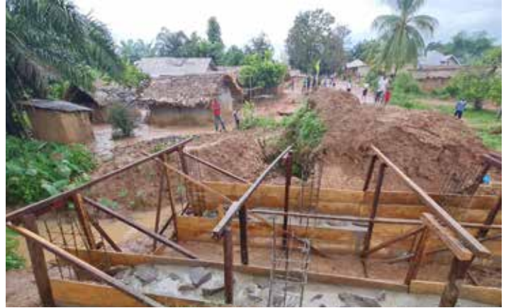
Travaux de construction de collecteur a Buta
