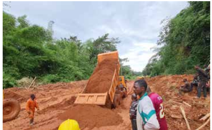
RN 4 purge de bourbiers
