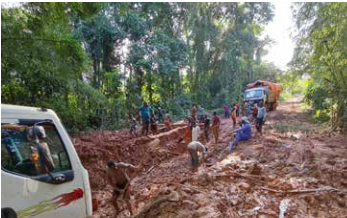
RN 4 avant le démarrage des travaux
