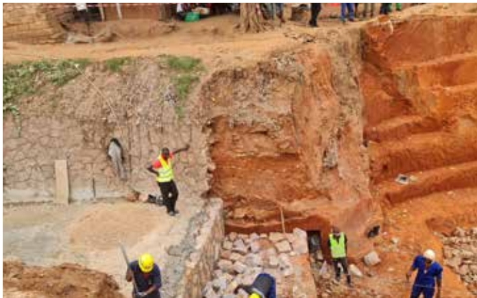
Travaux d'entretien de l'avenue Monga ndenge ( Mongala )
